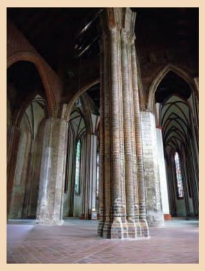
Die besondere Herausforderung bei der Sanierung der St. Marienkirche in Frankfurt / Oder galt der Rekonstruktion der im Innenbereich zum größten Teil vollständig zerstörten Innenpfeiler, da die hierfür hergestellten Formsteine den noch vorhandenen Originalsteinen nicht nur in Form und Farbe entsprechen mussten, sondern auch besondere statische Anforderungen zu erfüllen hatten.
