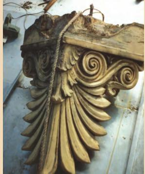
Doch die Erstellung von Negativformen allein genügt nicht - denn schließlich handelt es sich bei Terrakotta um eine Tonmasse, die einem bestimmten, prozentualen Schwindungsprozess unterliegt.
